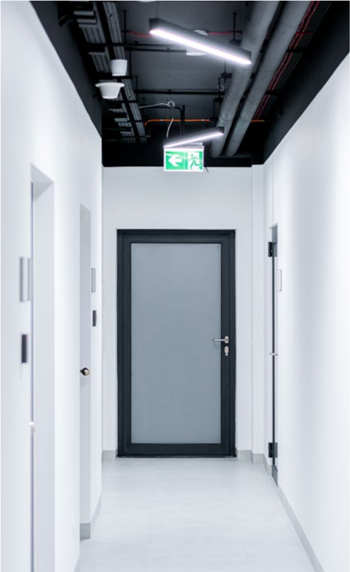
Die Verwendung der LED-Lampe DOT CS im Flur eines Mehrfamilienhauses.
